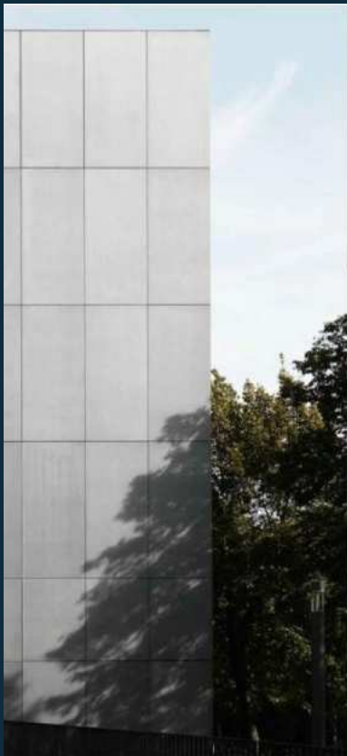
Esempio di facciata con utilizzo di pannelli in fibrocemento Marca RIEDER Modello Concrete SKIN
